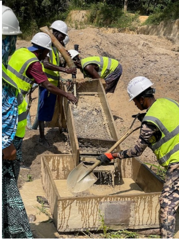
ロッカー（砂利洗浄機）
