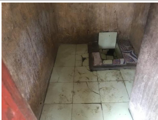
清掃され使用されているトイレ（1号棟）
