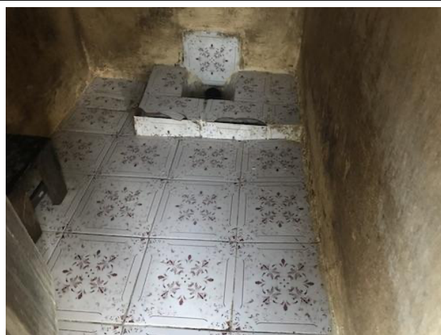
清掃され使用されているトイレ（2号棟）
