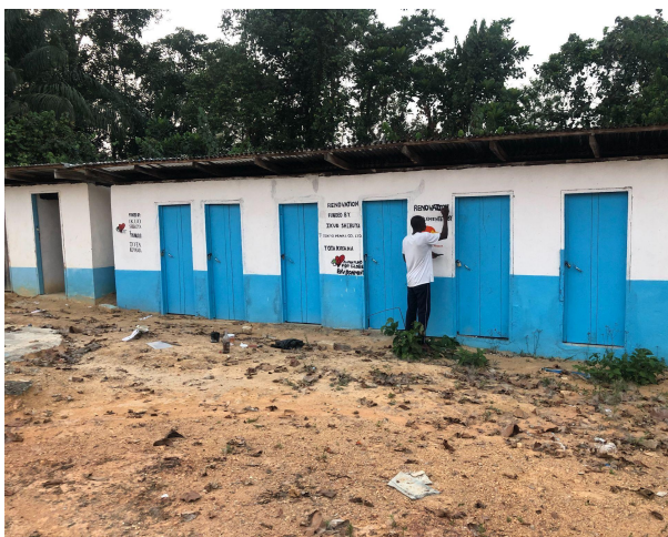
修繕された小中学校のトイレ
