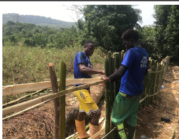
フェンス建設の様子
