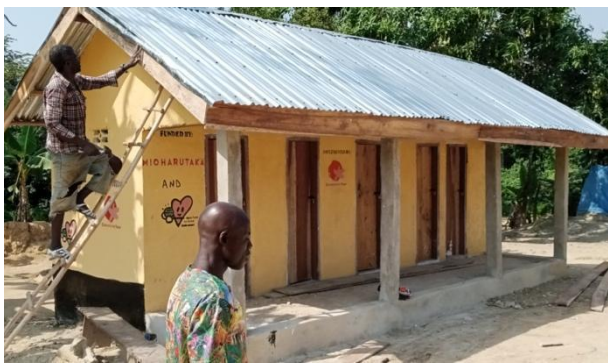
完成した公共トイレ第2号棟
