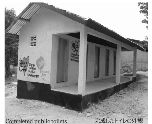
Completed public toilets 完成したトイレの外観
