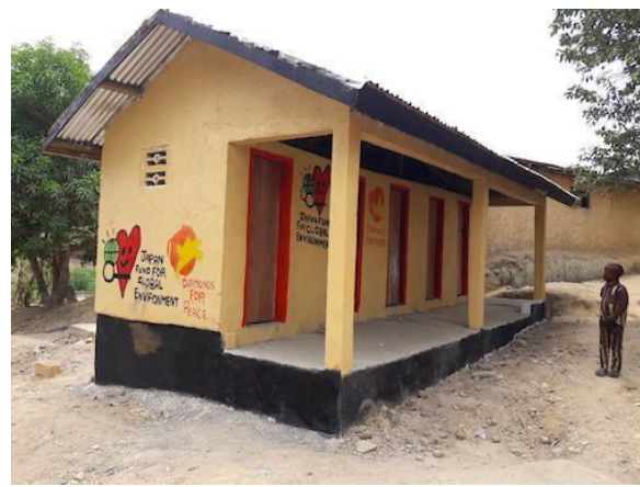
完成した公共トイレ
